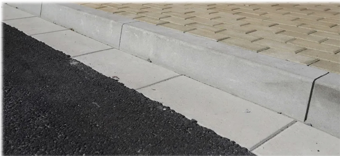
Ilustrační foto použití betonového krajiníku s přídlažbou podél asfaltové vozovky.
